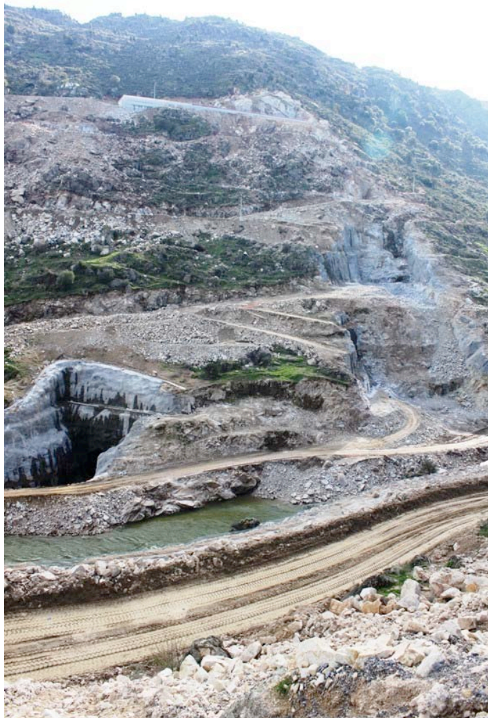
Figura 3 — A frente de obra da barragem do Baixo Sabor
